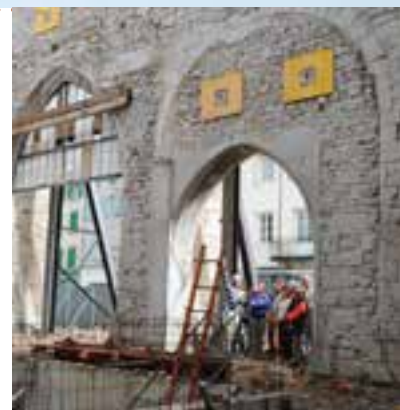
A titre exceptionnel, plusieurs groupes ont pu voir les travaux de l'intérieur, avec la mise à nu de l'ancienne église médiévale.
