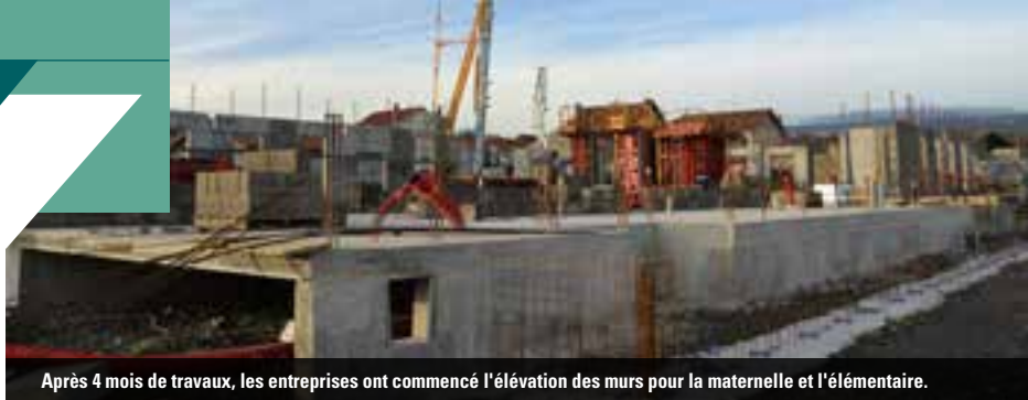
Après 4 mois de travaux, les entreprises ont commencé l'élevation des murs pour la maternelle et l'élémentaire.
