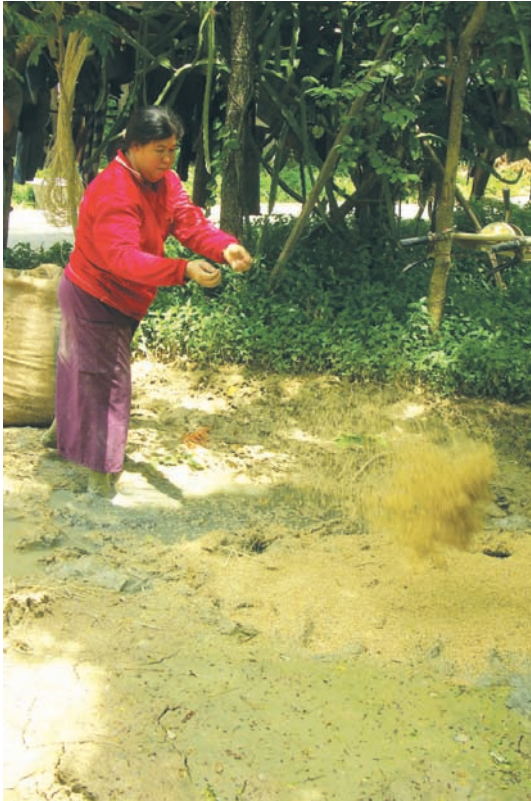
คนงานก่อสร้างกำลังโปรยแกลบลงไปในดิน ซึ่งถือเป็นส่วนประกอบสำคัญในการทำดิน
