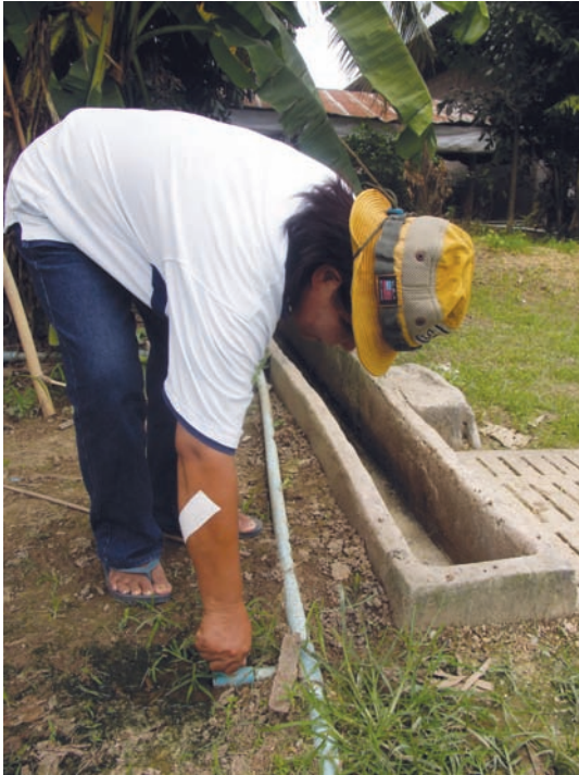
เกียงคำตรวจจาวาล์ท้อแก๊สจากบ่อหมักเพื่อส่งแก๊สไปยัง ครัวเรือนในชุมชน
