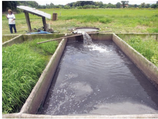
บ่อบำบัดน้ำในระบบการผลิตแก๊สจากชีวมวล
