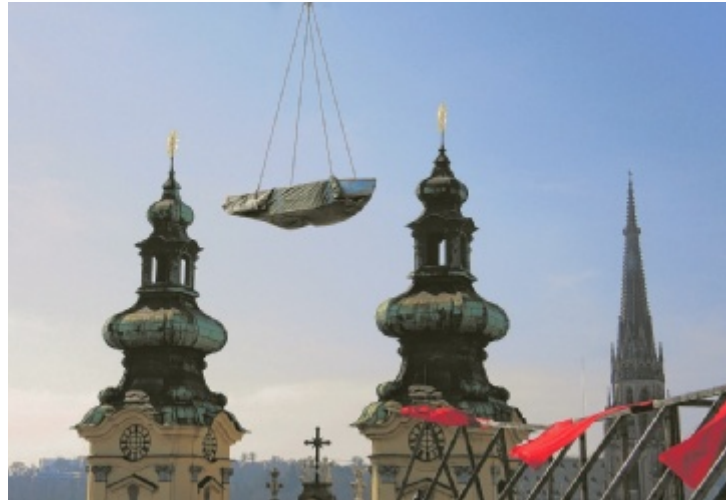
Die Vorbereitungen zum Höhenrausch.2 am Dach des OK laufen. Foto: Hauzenberger
