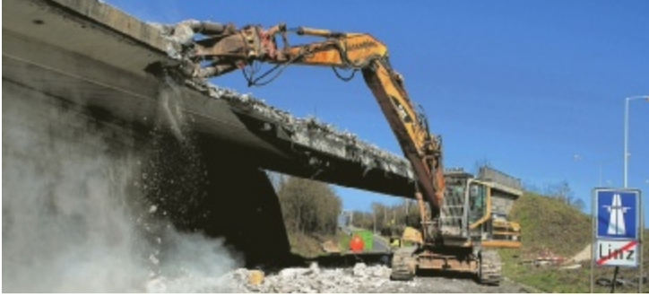
Nach den großen Bauarbeiten beim Knoten Salzburger Straße folgen nun noch abschließende Brückeninstandsetzungsarbeiten. Foto: Weibold
