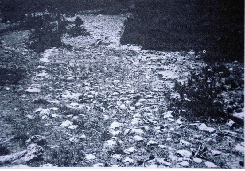
Resim 2: Kütahya, Pullar: Roma yolu (güneye doğru). (French 1992, 158, Resim 3)
