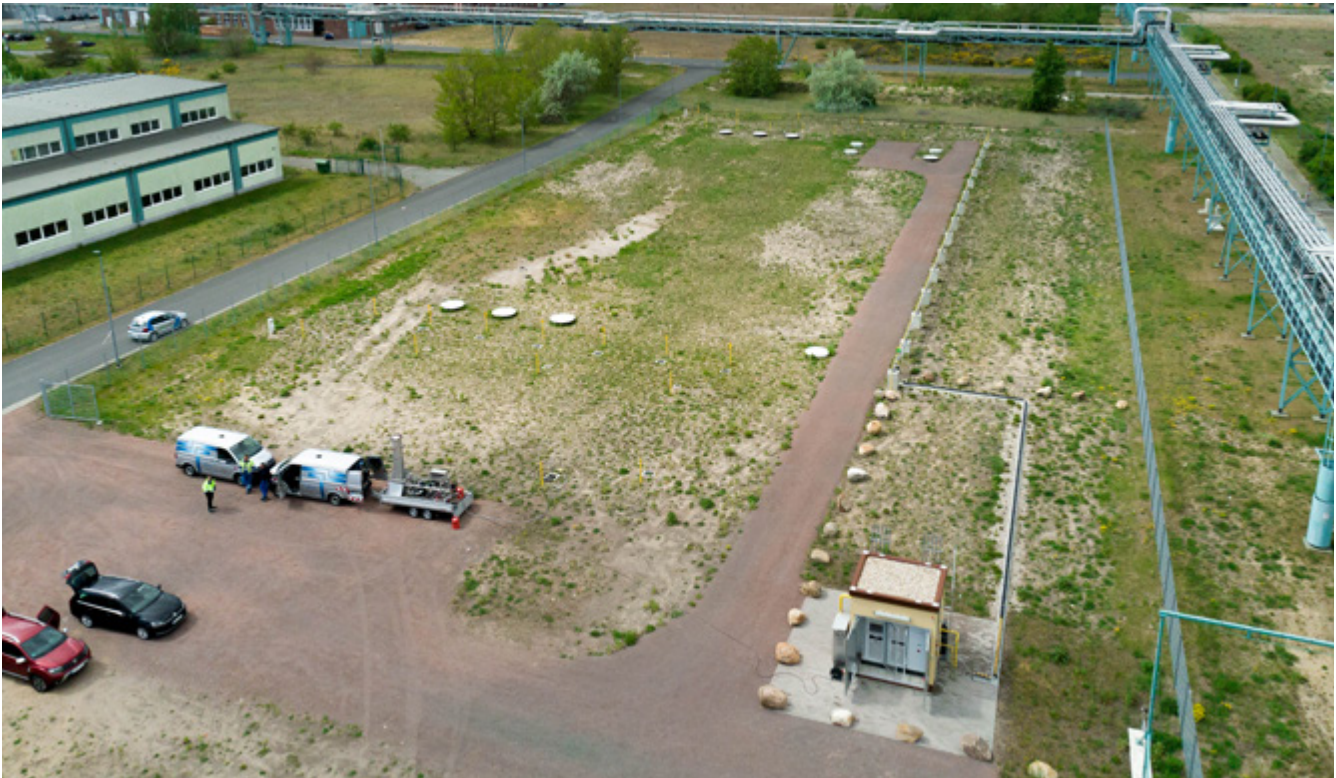
Das Gelände des Wasserstoffdorfs ist etwa 12.000 Quadratmeter groß. Die grauen Metallabdeckungen führen zu Schächten, von denen aus das unterirdisch verlaufende Verteilnetz sichtbar wird
