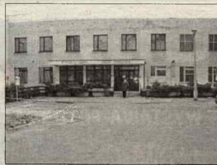
Część szpitalna Opolskiego Centrum Rehabilitacji
