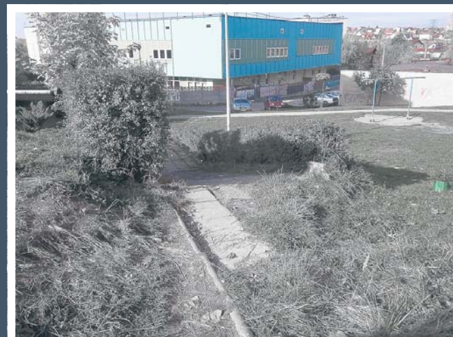
UL. INS. KOŚCIUSZKOWSKIEJ 64 – FRAGMENT SCHODÓW
