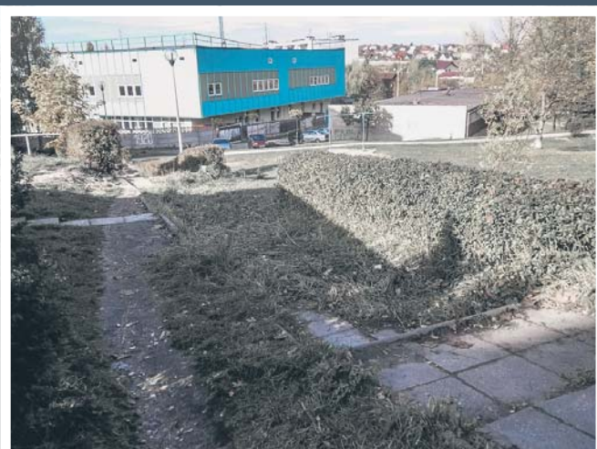
UL. INS. KOŚCIUSZKOWSKIEJ 64 – FRAGMENT SCHODÓW
