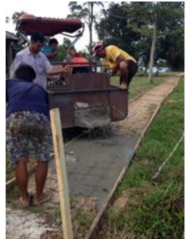
รองไวเมล ก่อนที่จะเทคอนกรีต
