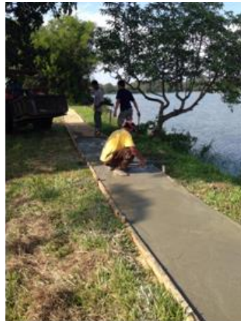
การพิมพ์ลายใบไม้บริเวณที่เทคอนกรีตแล้ว
