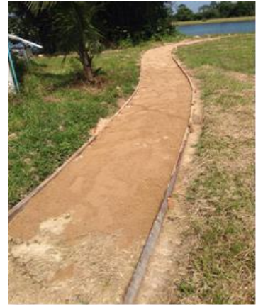
แนวเส้นทางก่อนเทคอนกรีต
