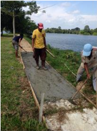
เทคอนกรีตเชื่อมกับเส้นทางเดิม
