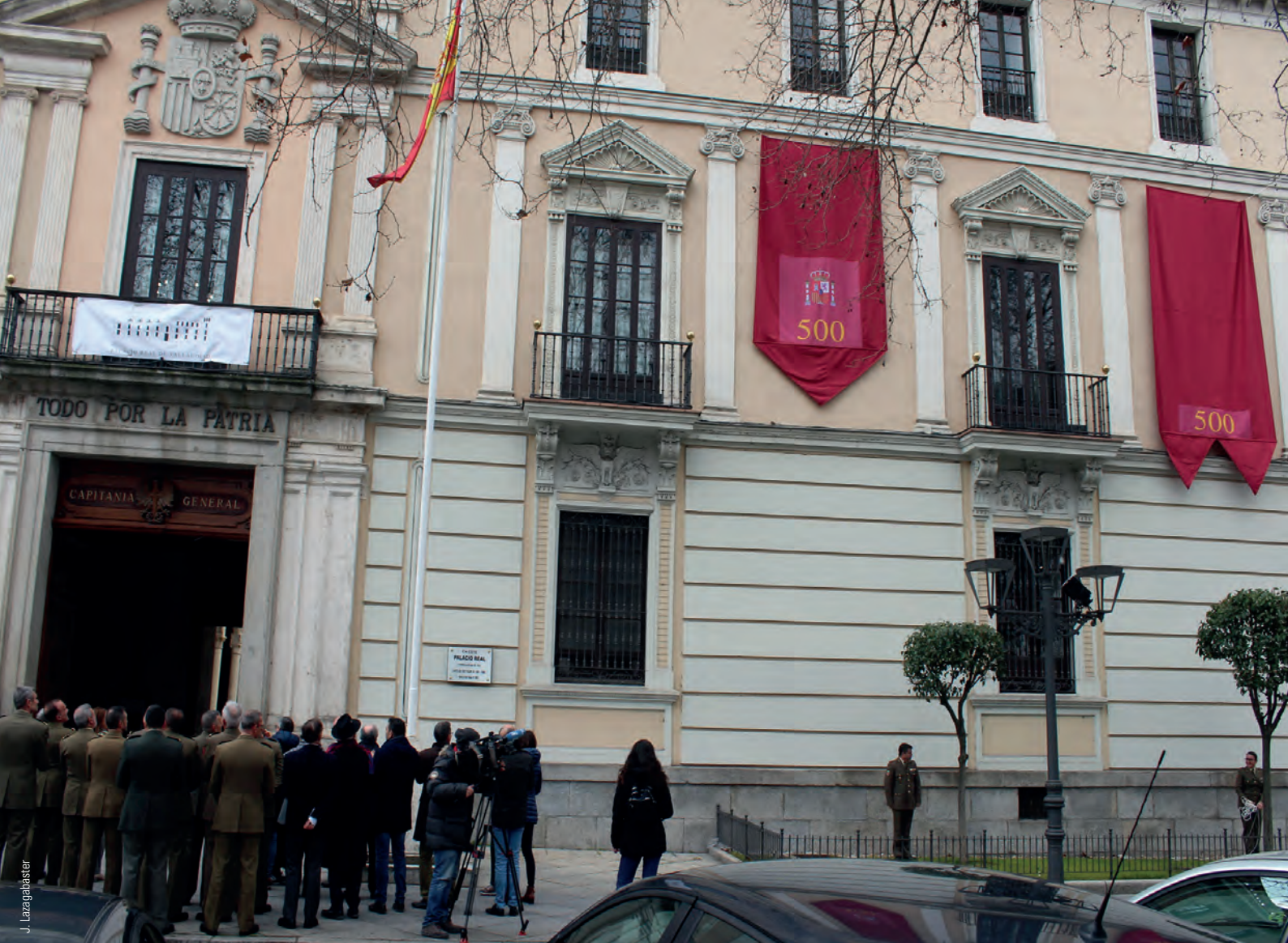
Fachada engalanada con reposteros y el logotipo de la conmemoración del V centenario del regio edificio (1523-2023), que a lo largo de su historia ha sido albergue de monarcas, centro neurálgico de la corte de Felipe III entre 1601 y 1606 e inmueble militar desde 1876.
