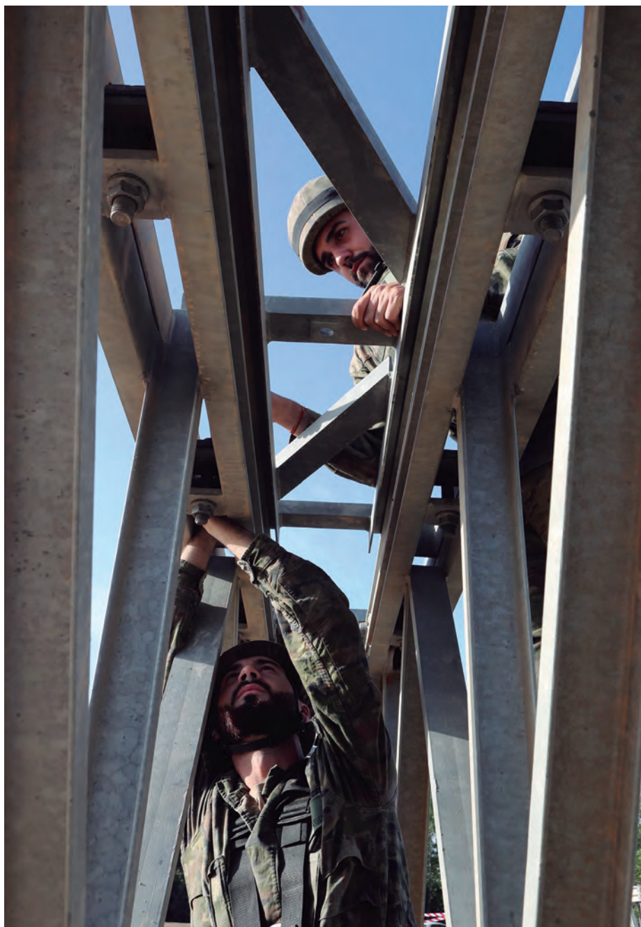
Dos militares de la unidad de tendido comprueban los ajustes de los paneles metálicos. Debajo, componentes del equipo de parque descargan material en la playa de lanzamiento.
