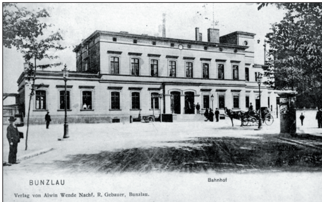
Dworzec kolejowy w Bolesławcu
