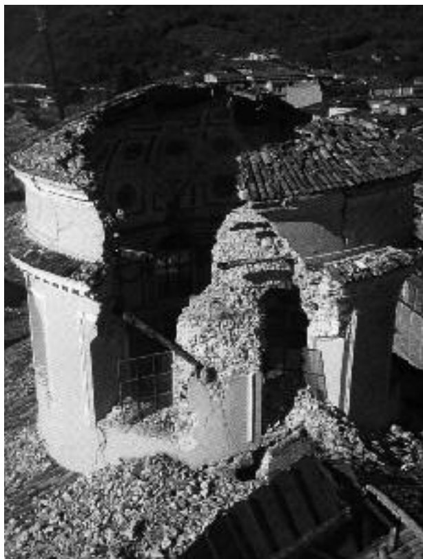
7. L'Aquila. Chiesa di Santa Maria del Suffragio, la cupola dopo il terremoto del 6 aprile 2009 (foto di G. Di Matteo).
