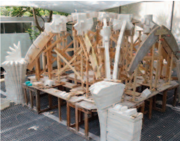
10. Montaje de la cimbra, la plataforma de trabajo y los pies derechos ya coronados con sus correspondientes claves.
