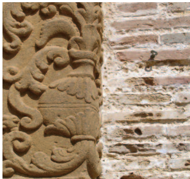
9. Piazza Armerina. Chiesa Madre, accostamento tra il portale scolpito in tufo e il paramento in mattoni facciavista.
