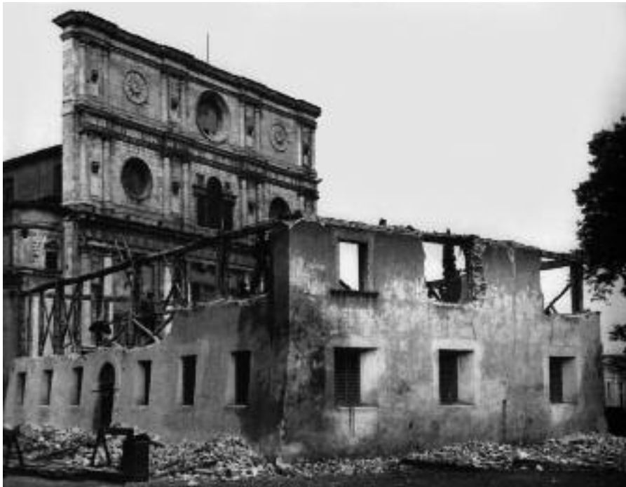
4. L'Aquila. Edificio baraccato settecentesco in corso di demolizione (foto d'archivio, per gentile concessione di CARSA Edizioni, Pescara).
