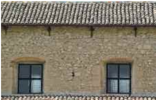
12. Petogna (L'Aquila). Vista dall'esterno dei paletti lignei (impalettature) di ancoraggio delle mensole delle capriate di una chiesa.
