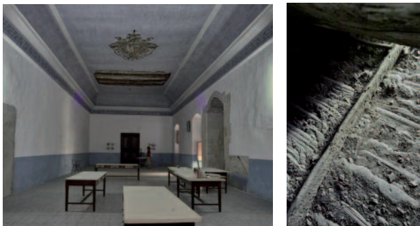
6-7. Xàtiva . Refectorio del Monasterio de Santa Clara; cerchas de madera y cañizo en el Monasterio de Santa Clara (fotografías J. Bérchez).
