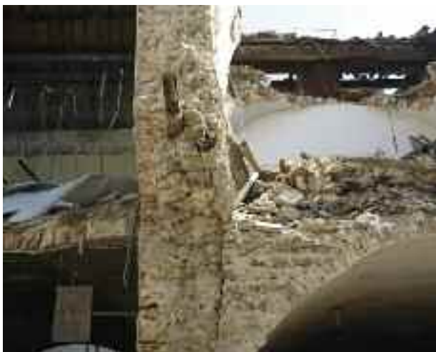
5. L'Aquila. Il collasso della facciata consente di riconoscere la presenza del radiciamento ligneo al centro della sezione del muro.
