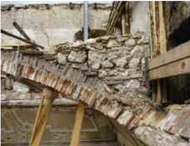
9. L'Aquila. Volta a padiglione a copertura del piano nobile in palazzo Ardinghelli, ricostruita dopo il 1703. All'imposta dei quattro fusi sono presenti elementi lignei reciprocamente collegati a mezzo legno e ancorati alle pareti esterne.
