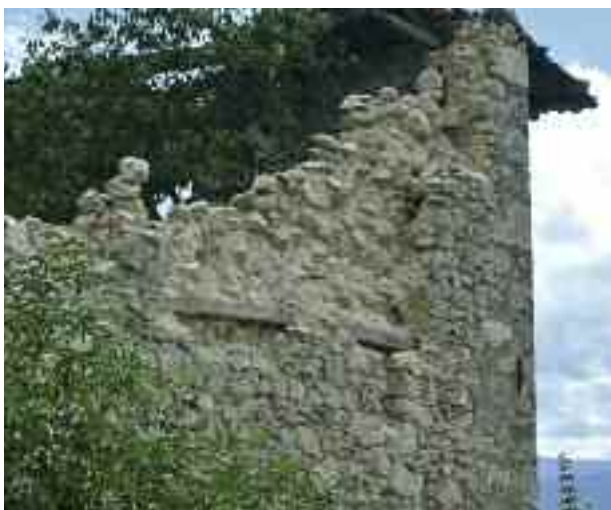
6. Poggio Picenze (L'Aquila). Un radiciamento realizzato con un elemento ligneo squadrato e, sull'angolo, il capochiave del radiciamento della parete ortogonale.
