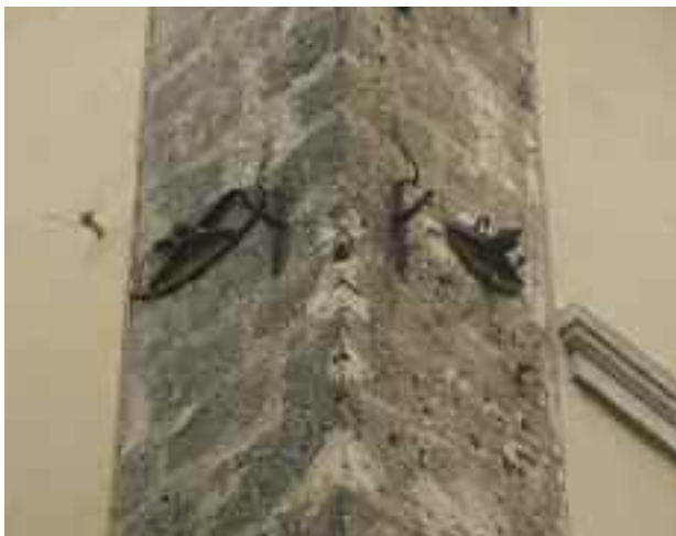
3. L'Aquila. I differenti capochiave sull'angolata muraria evidenziano la presenza di catene recenti (XX secolo) che si affiancano ai più antichi radicamenti lignei.
