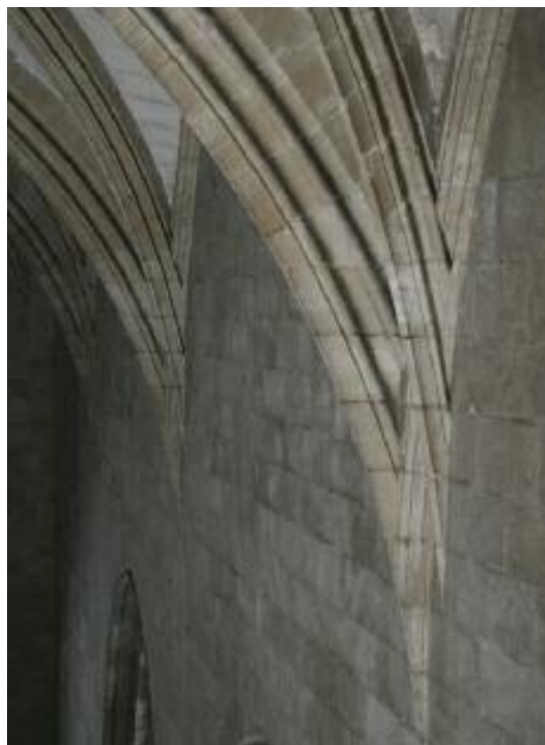
9. G. Sagrera, lonja de Mallorca, detalle del injerto de los nervios de la cubierta en el muro perimetral (foto de M. Morey).
