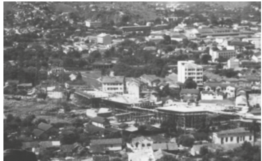
Construção do Viaduto de Madureira
