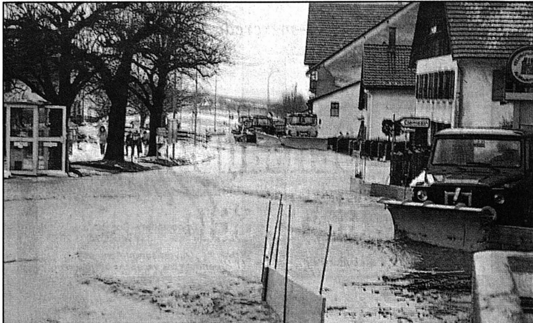
On avait surnommé Villiers, la Venise du Val-de-Ruz. Moins poétique, sur la route cantonale, le goudron avait été soulevé et arraché. photo a
