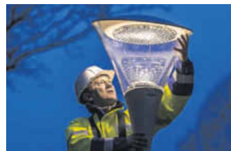
Wartung einer Straßenlaterne
