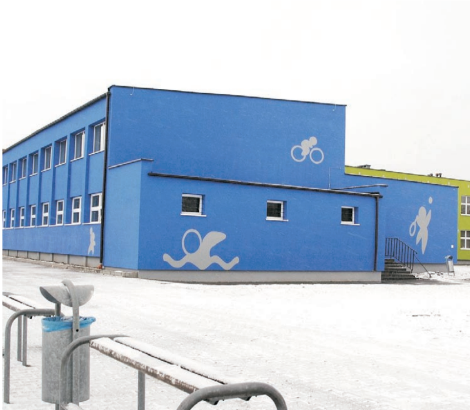
Tak po termomodernizacji wygląda budynek „Dwójki” od podwórka
