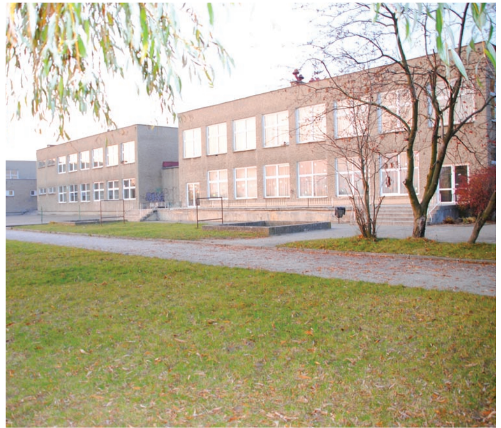
Tak wyglądał budynek „Dwójki” przed remontem
