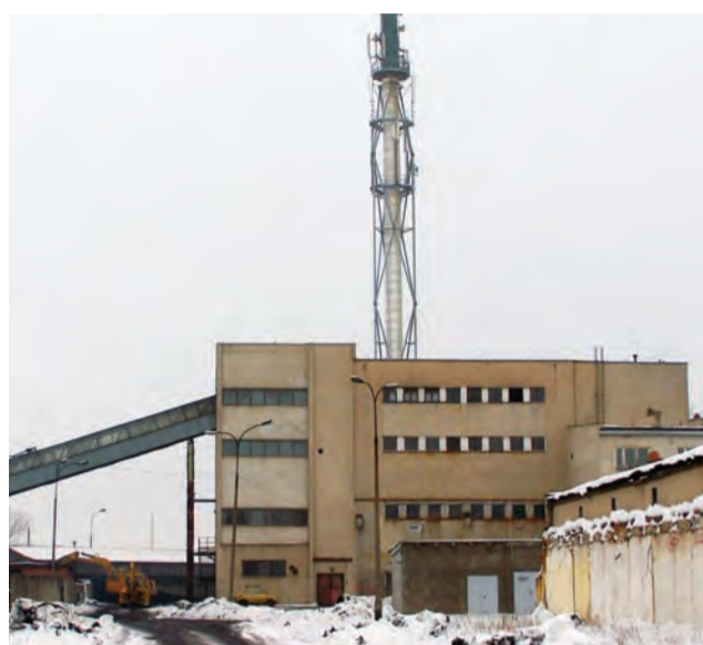
Kotłownia przy Syntexie to główny obiekt łowickiego ZEC i źródło ciepła dla większości łowickich osiedli.
